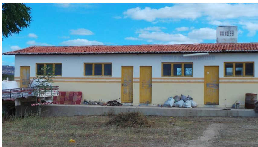
Figura 16. Espaço administrativo para o aterro controlado de rejeitos em São José do Sabugi – PB.
